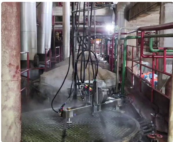
蒸发罐清洗现场实拍（二）
