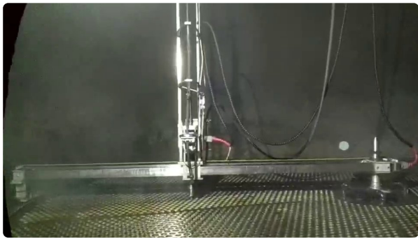
蒸发罐清洗现场实拍（一）
